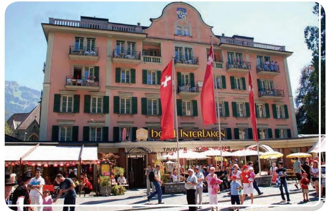
Die ehemalige Klostertaverne verbreitet immer noch historischen Charme. Das Hotel Interlaken wurde von der Familie Beutler mit viel Herzblut restauriert und mit der memon® Umwelttechnologie ausgestattet
